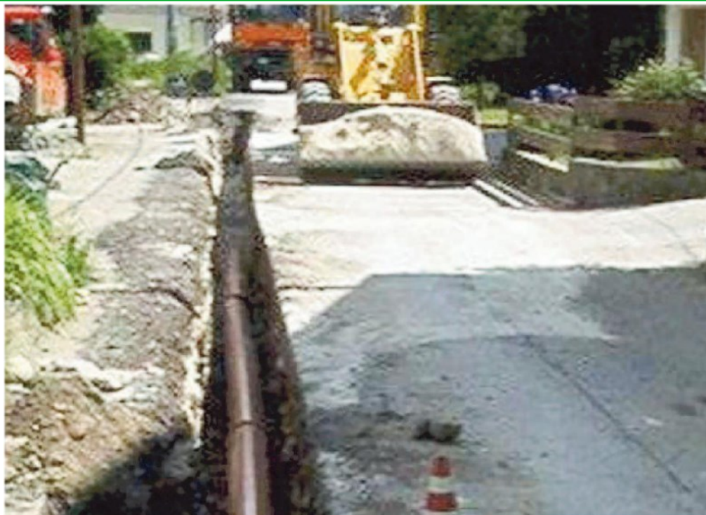
Lavori per la posa delle condotte del gas
